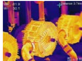
Inspección de equipos mecánicos
