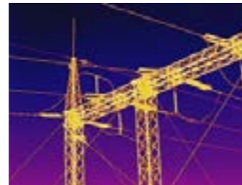
Inspección de servicios públicos
