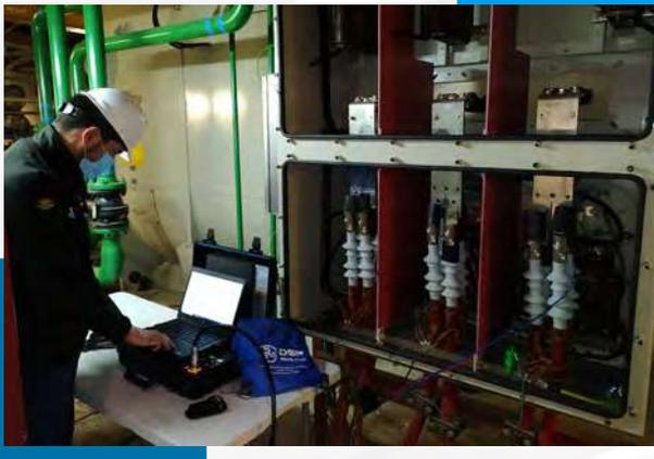
Las descargas parciales en la degradación de bobinados del estator de alta tensión dan lugar a pequeños pulsos de voltaje que viajan a través del devanado del estator. La magnitud y el número de estos pulsos dependen del grado del deterioro del aislamiento. Cuando la magnitud y el número de pulsos de voltaje de descarga parcial aumentan, la tasa de deterioro del aislamiento eléctrico también está aumentando
