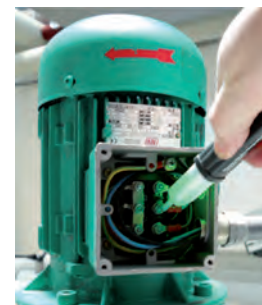
Reconocimiento de fase L2 e indicación del correcto sentido cíclico de las fases
